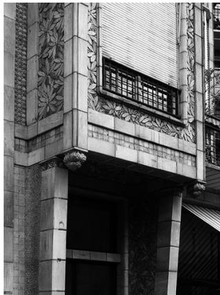
Abb. 36. Die Spindel als unteren Abschluss des Erkers verweist auf den traditionellen Holzbau
